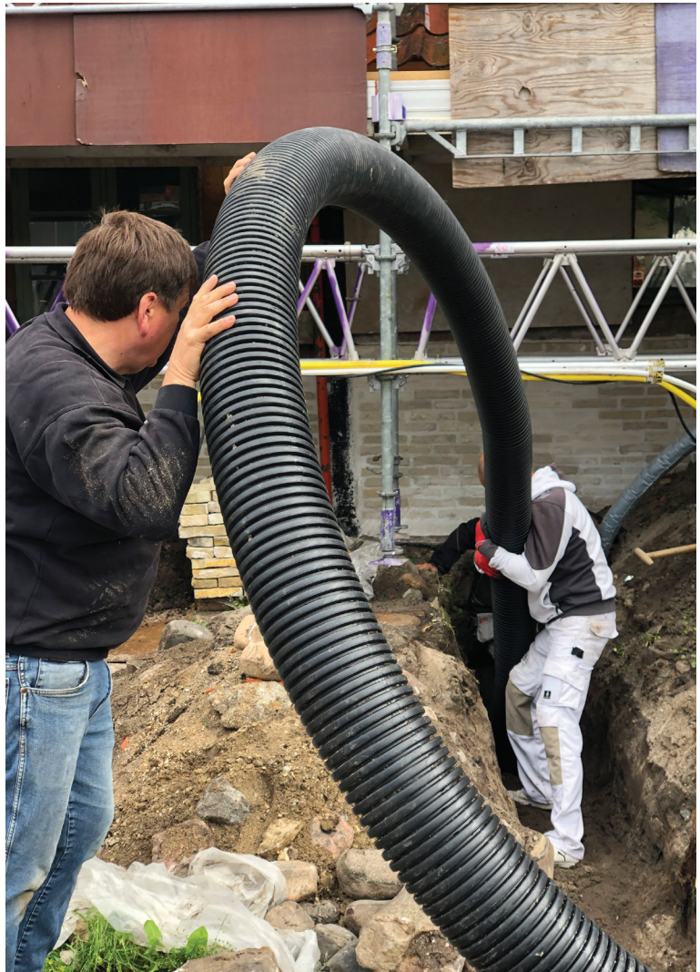
Der bliver kæmpet med at indføre varmeledningen under soklen
