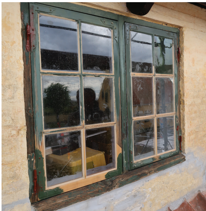
Vindue nænsomt istandsat til maling med linoliemaling
