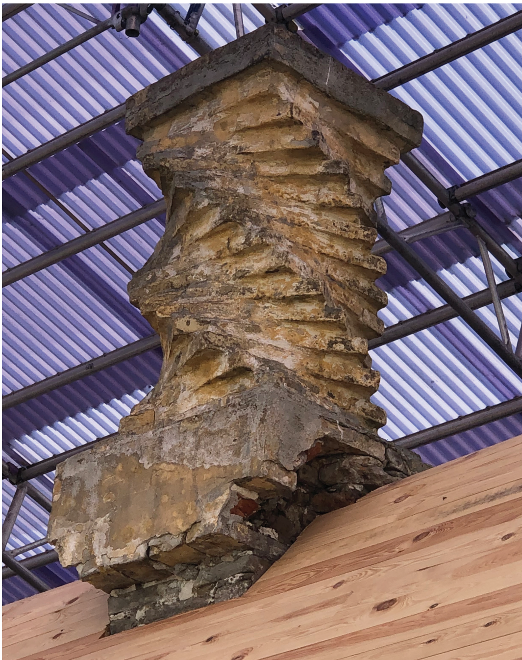
Den karakteristiske snoede skorstenspipe blev istandsat og kalket
